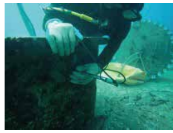
防食状況点検
