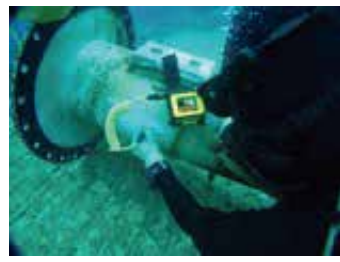
板厚状況点検
