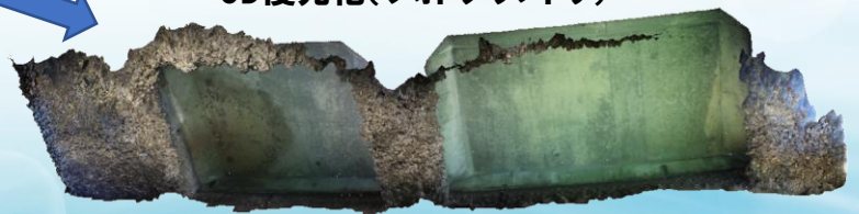
(棧橋の桁下の様子)
