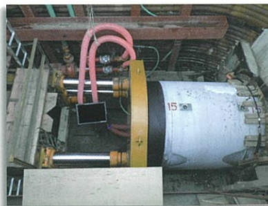
推進機による掘削
