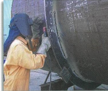
溶接、塗装状況
