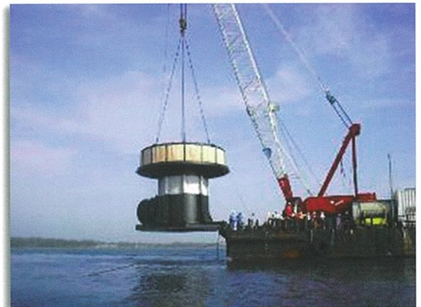
取水設備の設置
