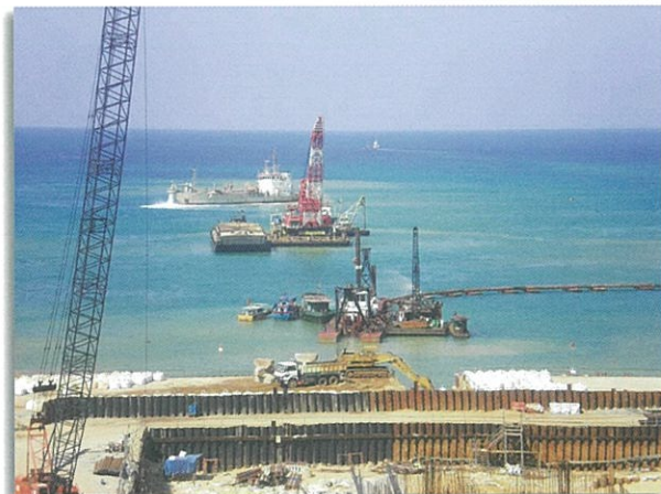
海上作業全景
